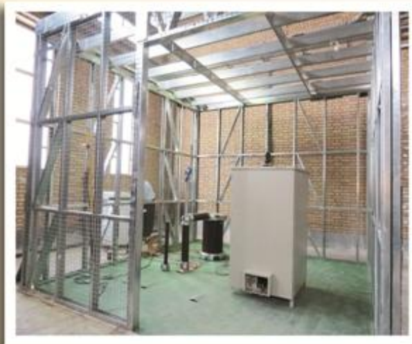
تصویر شماره ۵: یک دستگاه NGR ساخته شده به وسیله تابلوی مدل
