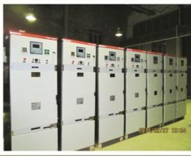
تصویر شماره ۲: نمونه تابلو های ۲۰ کیلوولت مدل TA-MVD
